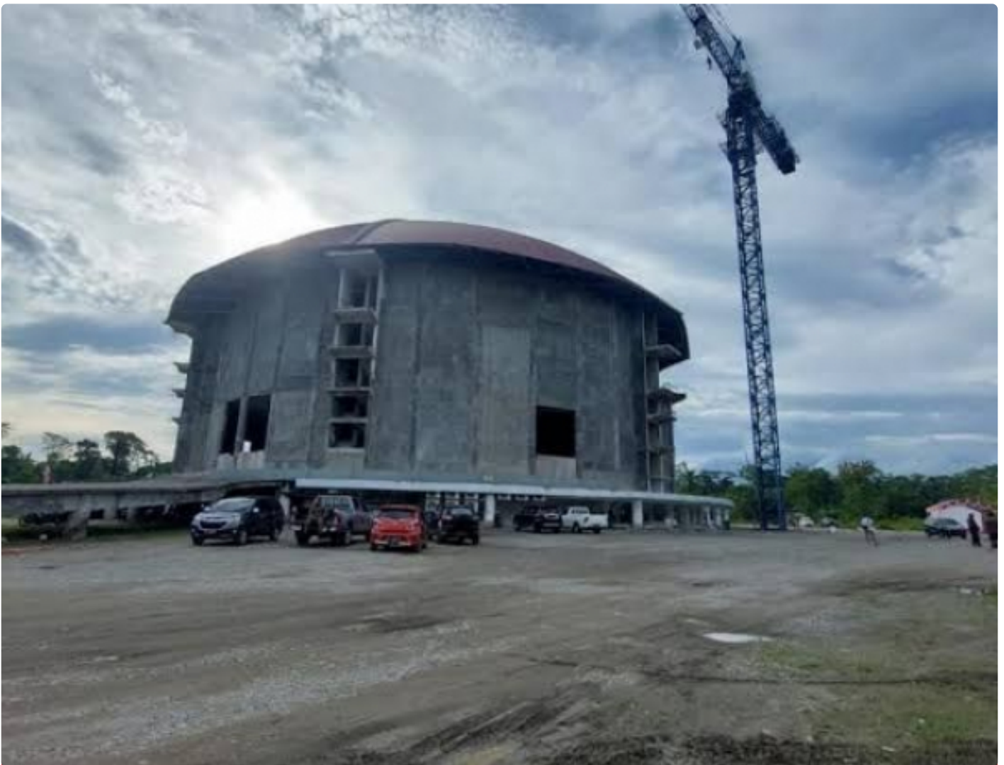
Pembangunan Gereja Kingmi Mile 32
